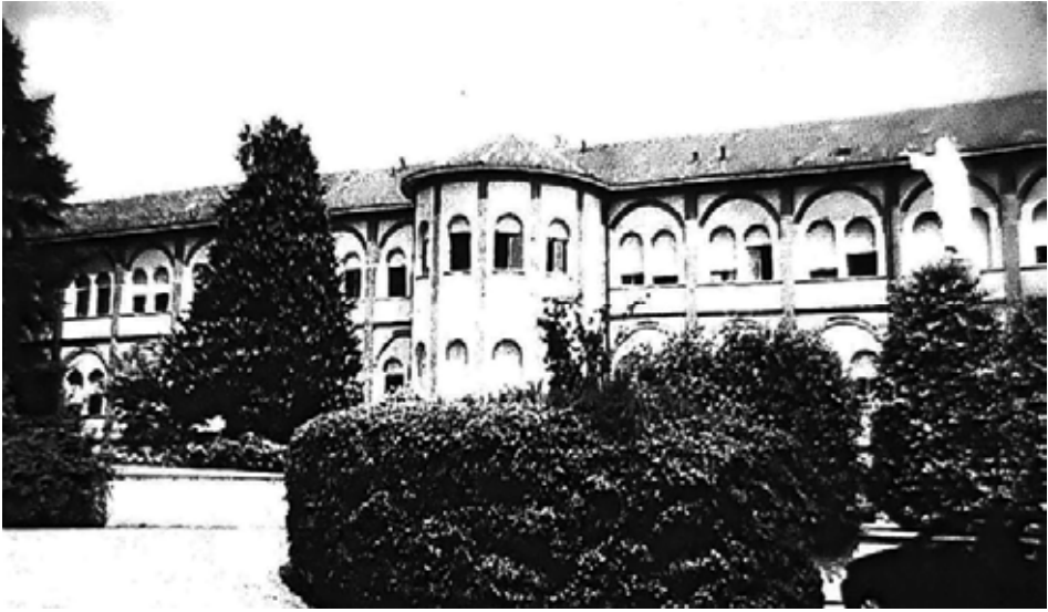
مبنى تمرير الراهبات
